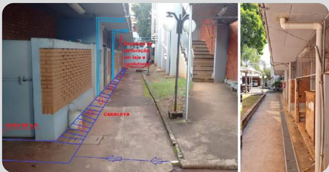
Sistema de drenagens de águas pluviais feitos entre os blocos D-térreo e K
