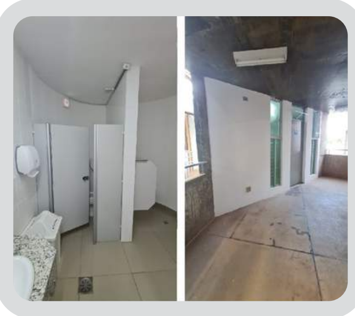
Fotos do banheiro masculino reformado
