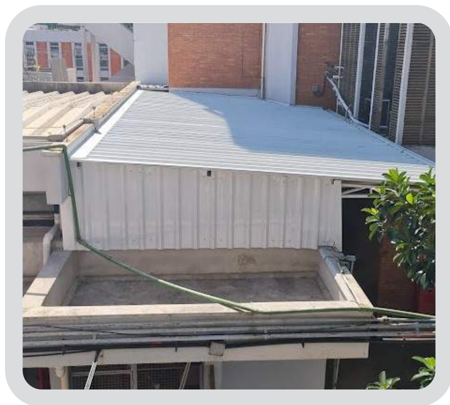
Bloco D térreo, após a cobertura e impermeabilização da laje.
