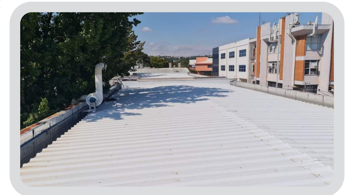
Bloco E, telhado reformado.
