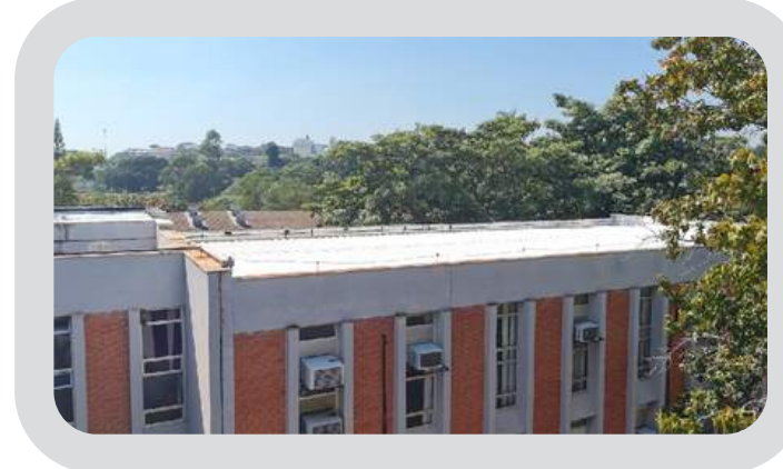
Imagem do telhado do Bloco H já reformado
