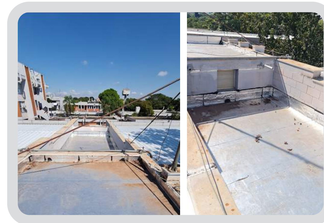
Fotos da manta reformada no Bloco E
