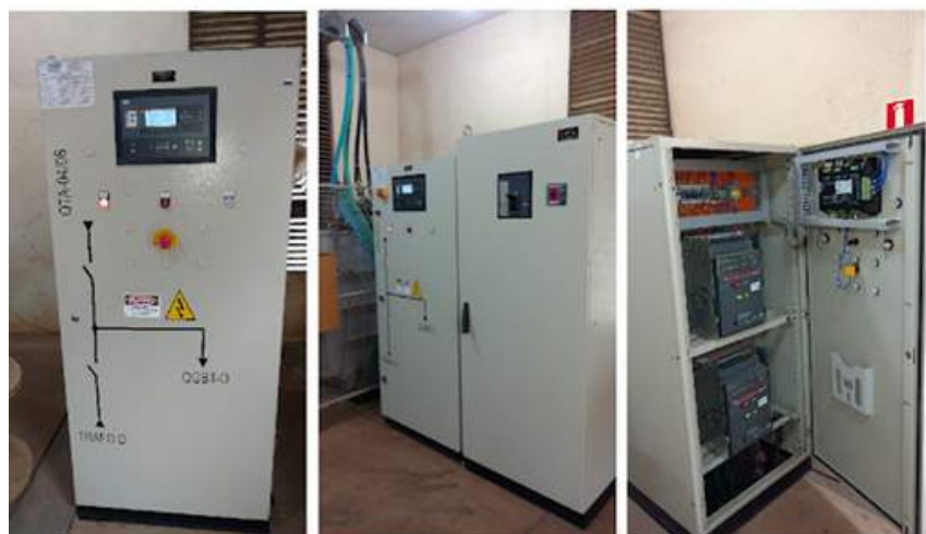
Detalhes dos quadros de transferências dos transformadores e geradores, com seus respectivos controladores
