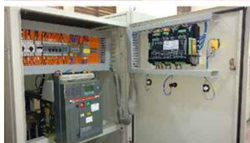
Detalhes dos quadros de transferências dos transformadores e geradores, com seus respectivos controladores
