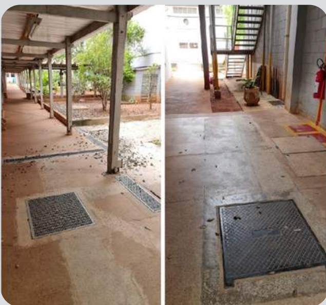
Sistema de drenagens de águas pluviais feitos entre os blocos D-térreo e K
